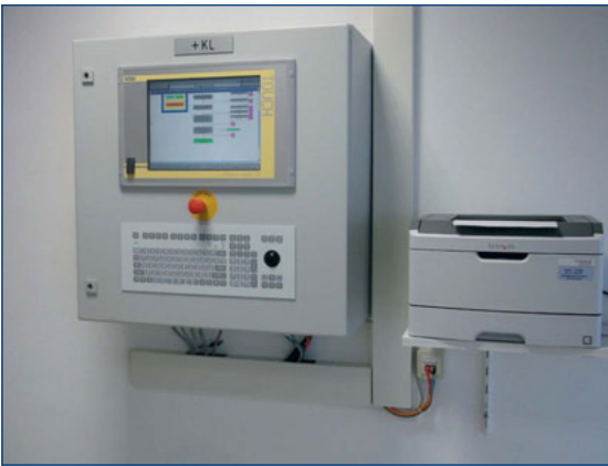
Abb. 2 Maßnahmenbeispiel - Ordentliche Verlegung von Leitungen und Kabel
